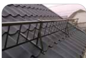
Suport parazăpadă țiglă metalică
