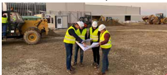
20 Februarie 2020: montarea utilajelor la fabrica Petra Pavaje Ploiești
