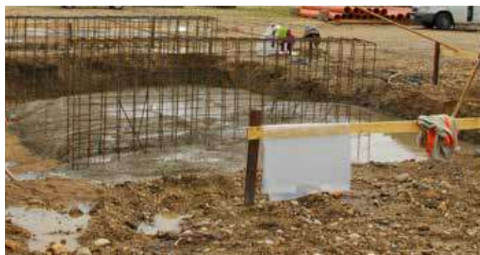
30 martie 2011: lucrări fabrică de asfalt
