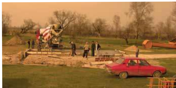
12 aprilie 2006: debutul construcției stației de betoane
